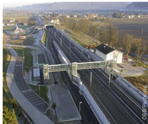
Modernisierter Bahnhof Grafenstein
